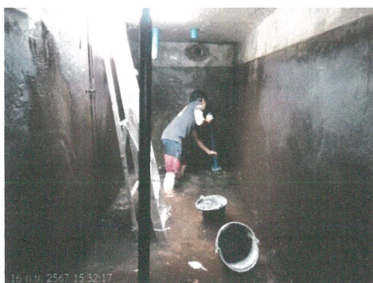
รูปภาพที่ 2.33 ถังเก็บน้ำสำรองและการล้างถัง
