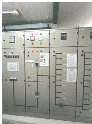
รูปภาพที่ 2.45 Capacitor Bank
