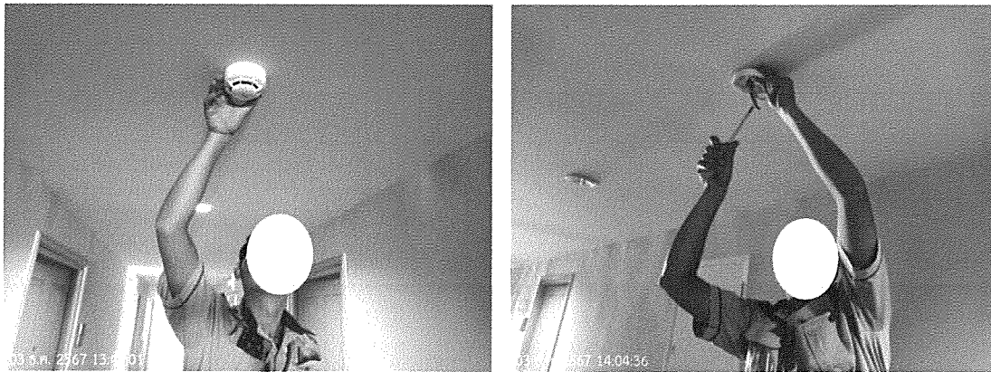
รูปภาพที่ 2.54 การตรวจสอบอุปกรณ์ป้องกันอัคคีภัย
